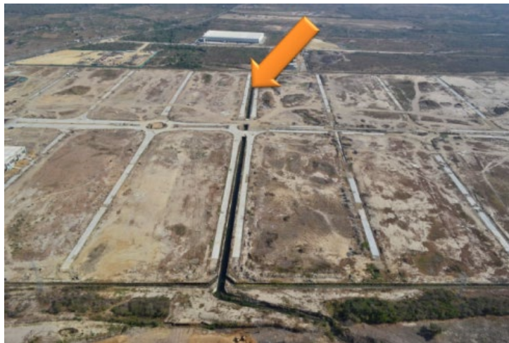
Figura 38 Modificación del cauce y canalización del Arroyo Caña
