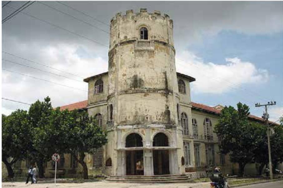
Sede del antiguo CODEBA (Carrera 41 Calle 51 esquina)
