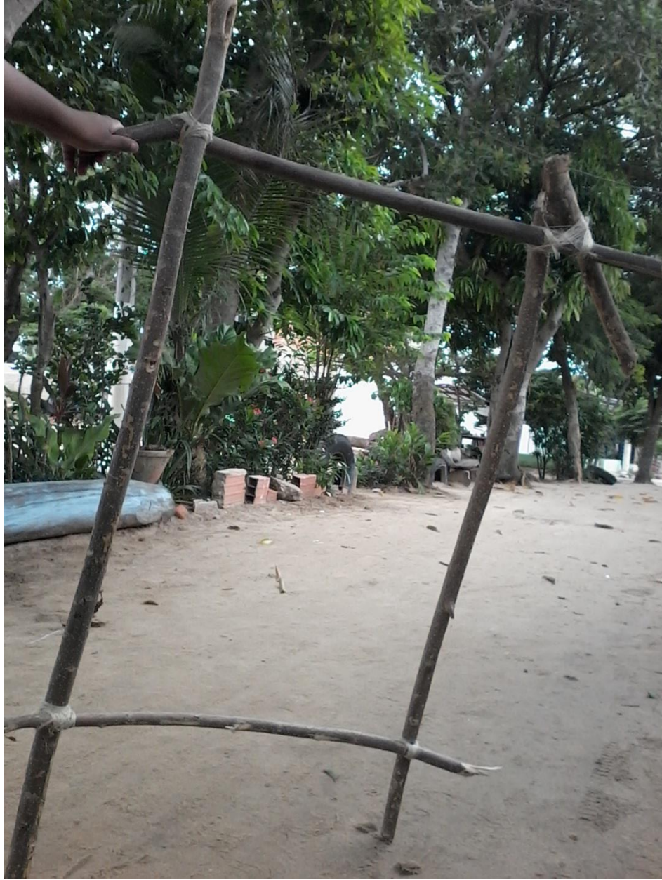
Figura 64. Parte de la estructura construida, fotografía por: Carlos Rodríguez
