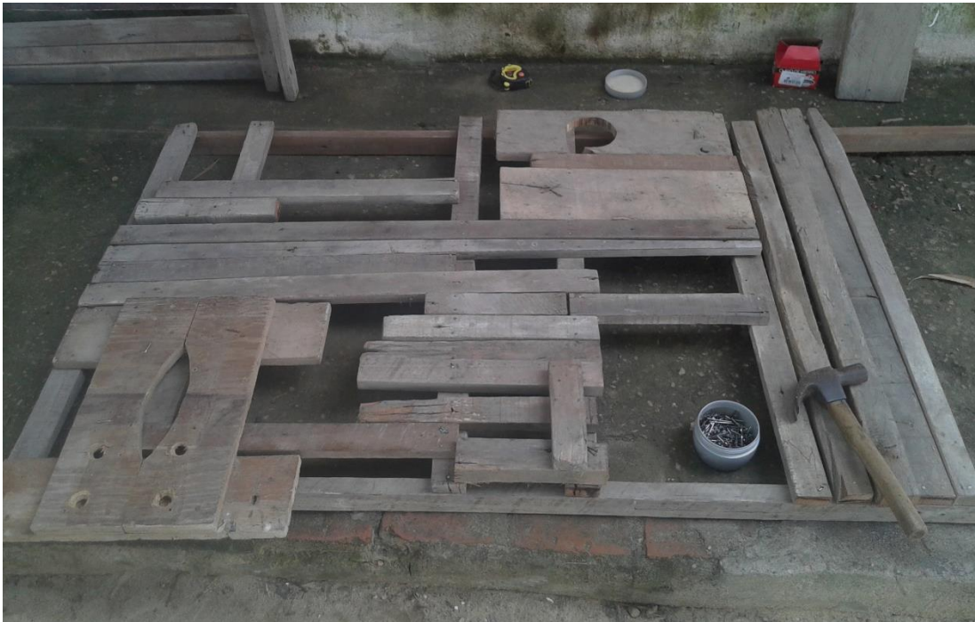
Figura 74. Pared lateral de la chaza en construcción, fotografía por: Nabid Rodríguez Meriño, 2019.
