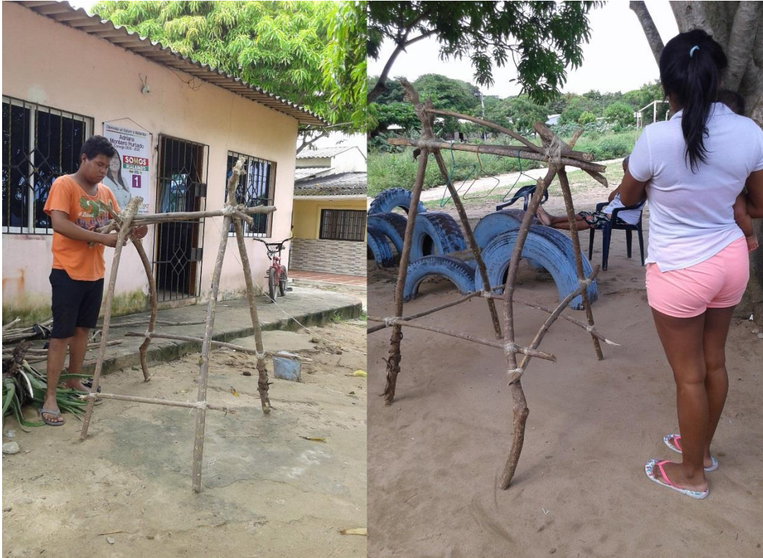
Figura 65. Estructura construida con palos de Matarratón, fotografía por: Carlos Rodríguez.
