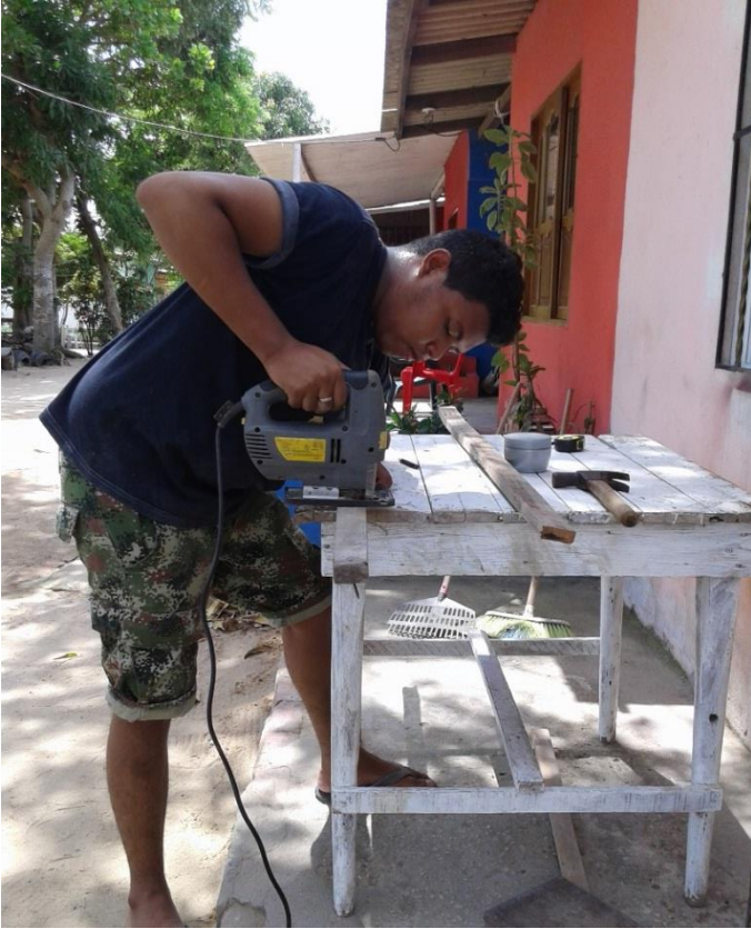
Figura 73. Corte de listones con madera encontrada para la construcción de la chaza, fotografía por: Carlos Rodríguez, 2019.
