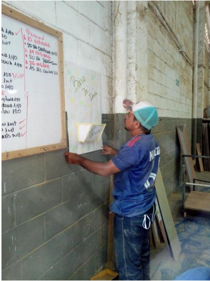
Fig. 3 Instalación del buzón finalizada
